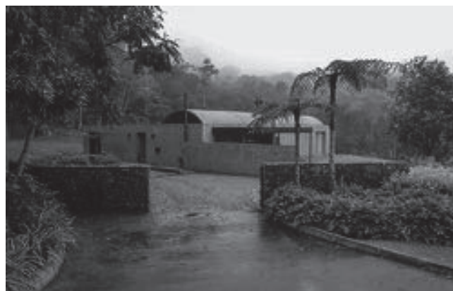
Figura 3.6 Marco Aurelio Montes Botero, casa Arrayanes, Envigado, 2003, aproximación Fuente: fotografía de Margarita Botero Botero
