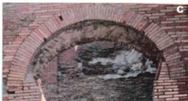
Figura 1. A: Estructura de madera para la construcción de arco o bóveda. B: Arco en opus caementicium. C: Arco en opus latericium.
