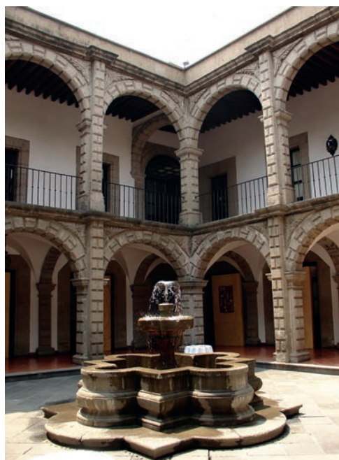
Figura 1.2 Patio del antiguo claustro del Convento de San Felipe Neri “el Viejo”, 1684. Arquitecto Cristóbal de Medina Vargas. Fuente reconstruida en el siglo XX. Hoy oficinas de la Secretaría de Hacienda y Crédito Público, calle de República del Salvador, Centro Histórico de la Ciudad de México. Foto: Martha Fernández.
