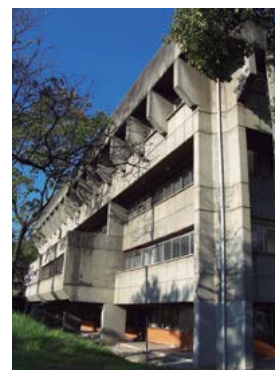
Figura 3.21 Los quiebrasoles y el corredor externo perimetral: respuestas contextuales
