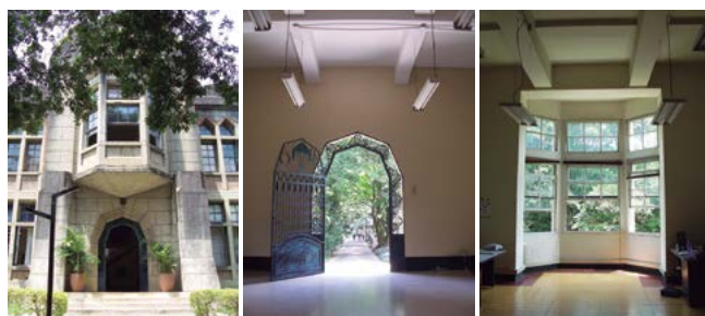
Figuras 3.5, 3.6 y 3.7 El torreón central del acceso, su hall interior y su oficina del segundo nivel
