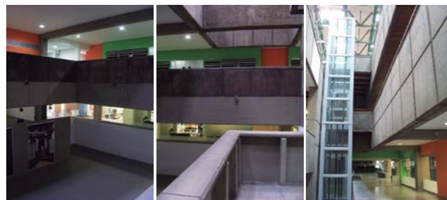
Figuras 3.17, 3.18 y 3.19 El núcleo central: articulador dinámico del edificio
