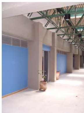
Figura 3.22 Las claraboyas, la estructura de la cubierta y las circulaciones del cuarto piso: luz, integración y perspectiva amplia
